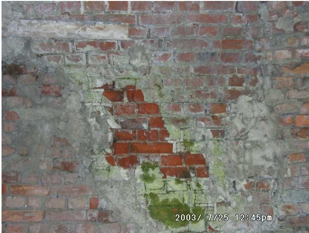
Fot. 13 Spękania i zniszczenia sklepienia od strony północnej
