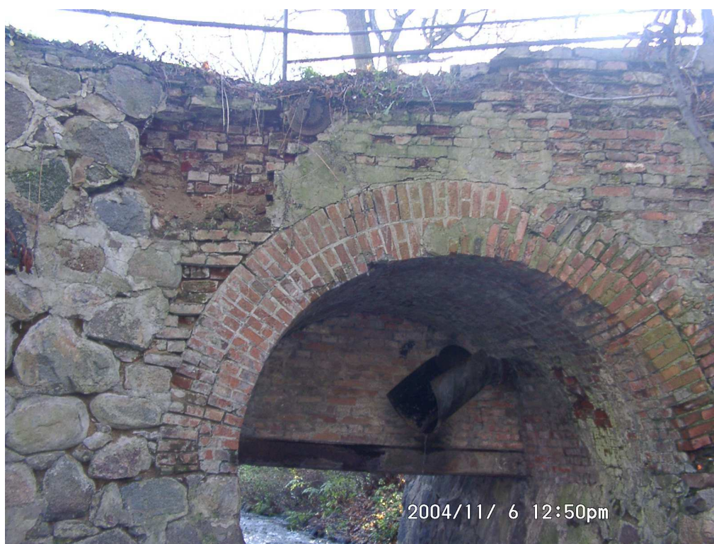
Fot. 6 Widok mostu od strony północnej
