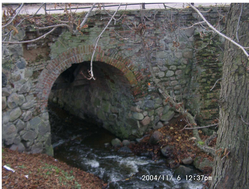
Fot. 5 Widok mostu od strony północnej
