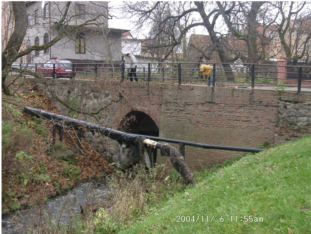
Fot. 1 Widok mostu od strony południowej
