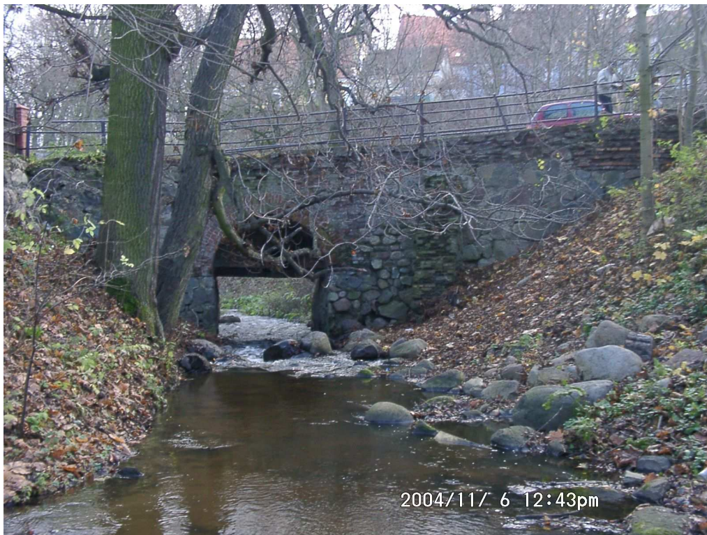
Fot. 4 Widok mostu od strony północnej – skrzydło prawobrzeżne
