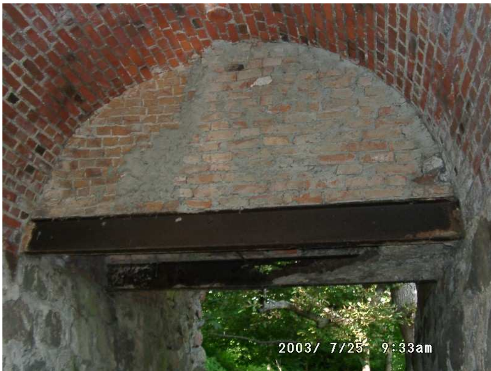
Fot. 10 Ścianki ceglane na dwuteownikach stalowych – konstrukcja podpierająca osłabione otworami sklepienie. Wewnątrz znajdują się rurociągi (fot.11,12)
