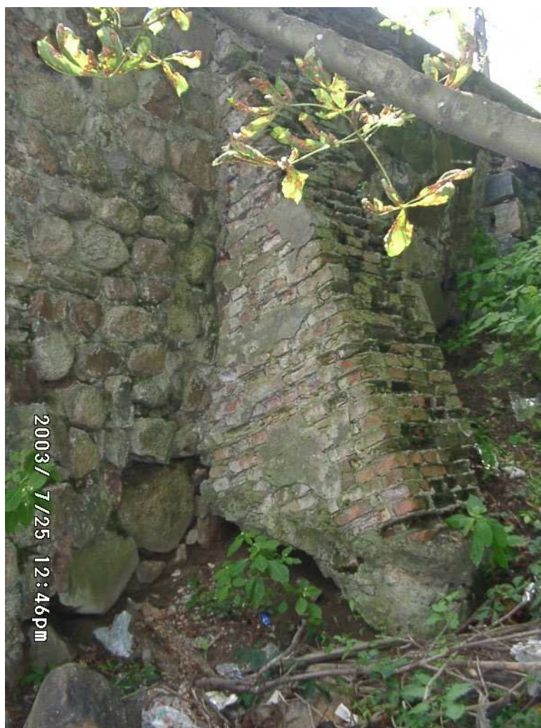
Fot. 15 Przypora od strony północnej, na prawym brzegu
