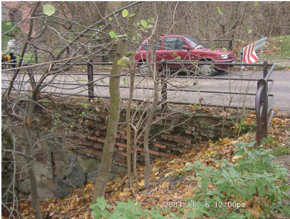
Fot. 3 Widok mostu od strony północnej – skrzydło prawobrzeżne
