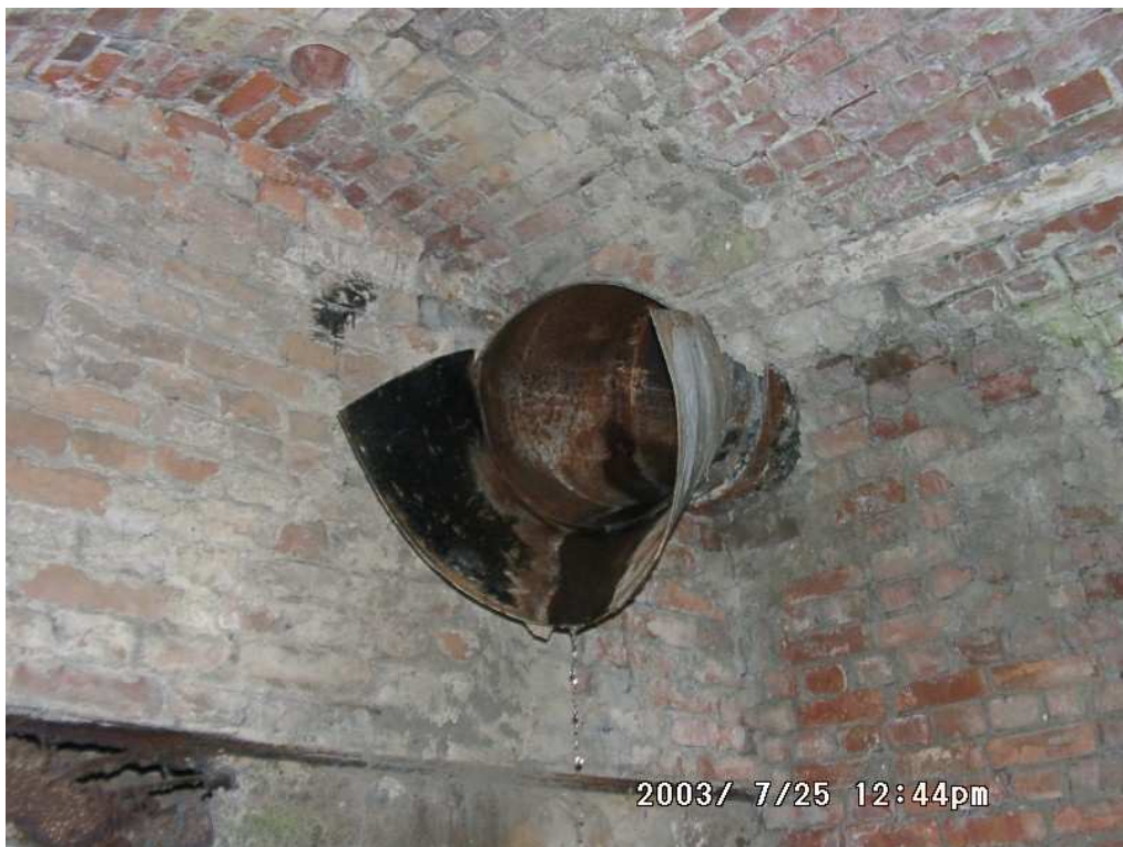
Fot. 12 Wylot kanalizacji deszczowej
