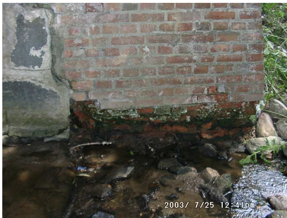
Fot. 16 Domurowany ceglany fragment przyczółka lewobrzeżnego od strony południowej
