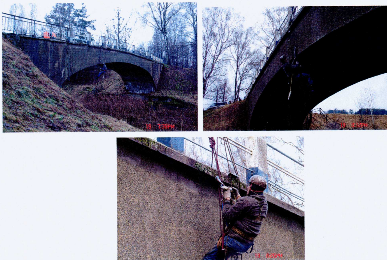
Fot. 32, 33, 34. Badanie nieniszczące betonu w pobocznicach mostu
