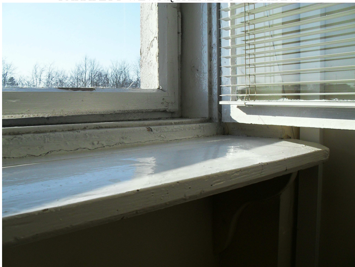
Fot. Nr 21 Parapet wewnętrzny– okno typ 6
