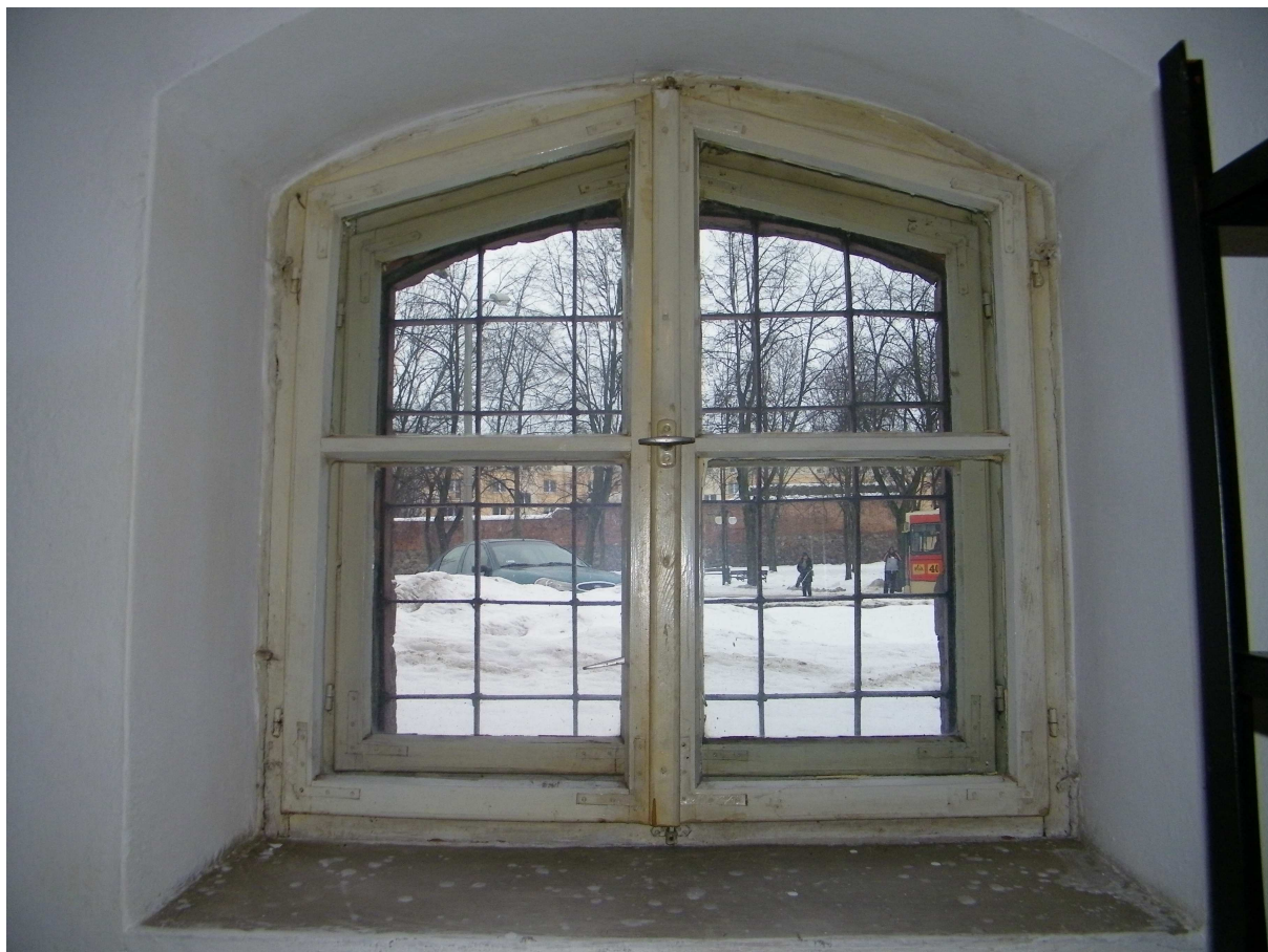
Fot. Nr 7 Okno typ 10 widok od wewnątrz
