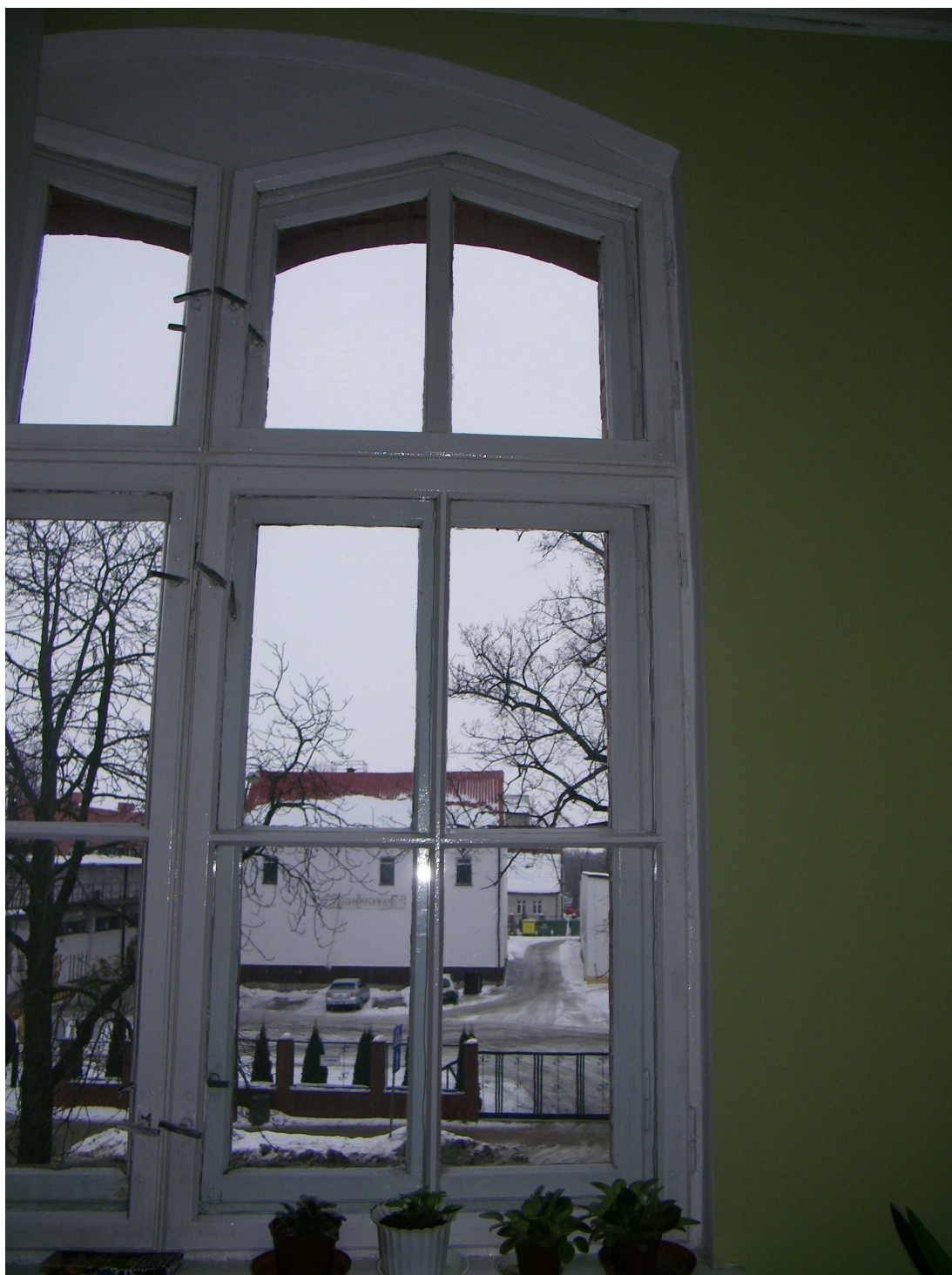
Fot. Nr 15 Okno typ 5 widok od wewnątrz
