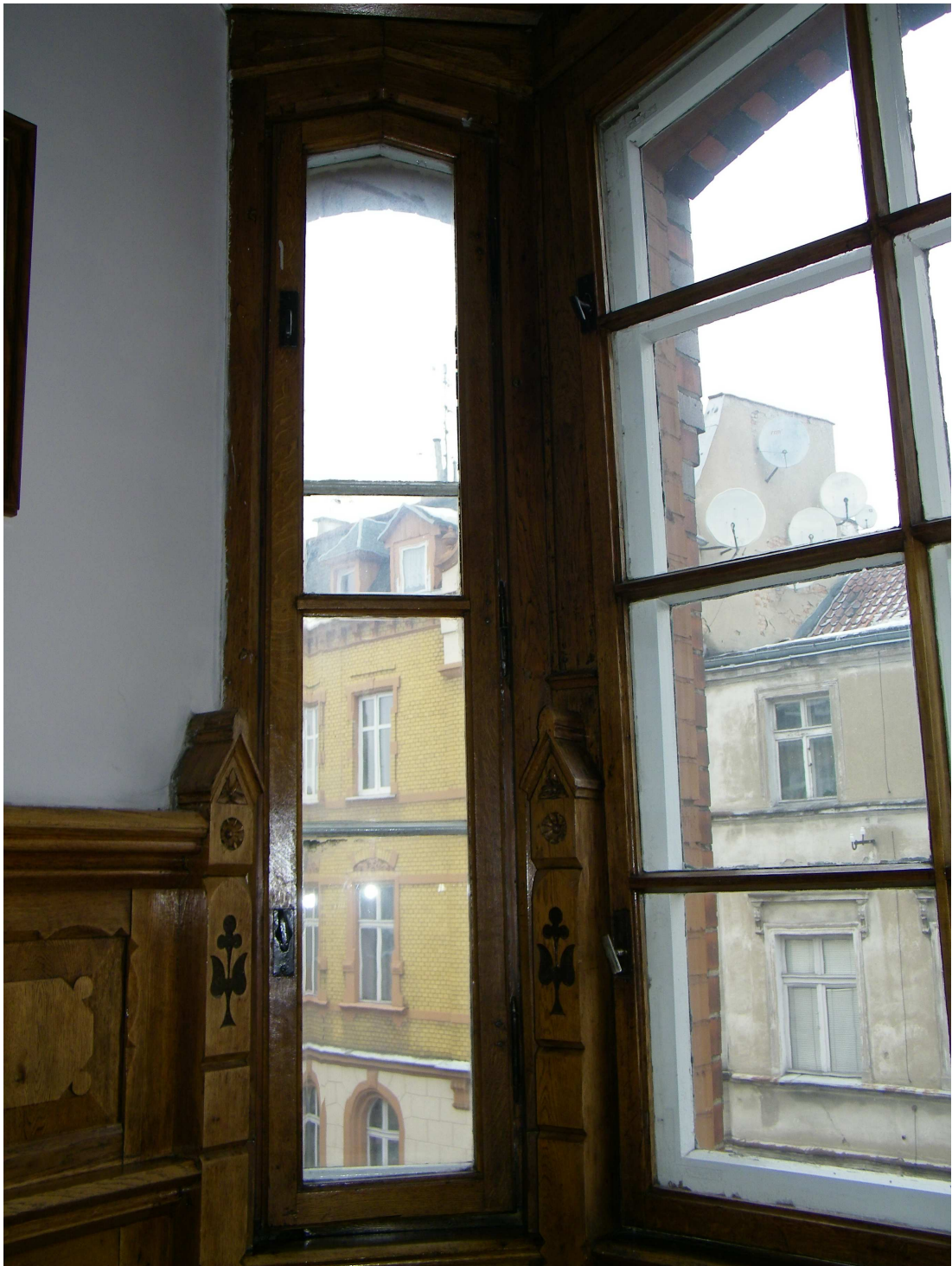
Fot. Nr 11 Okno typ 1 widok od wewnątrz
