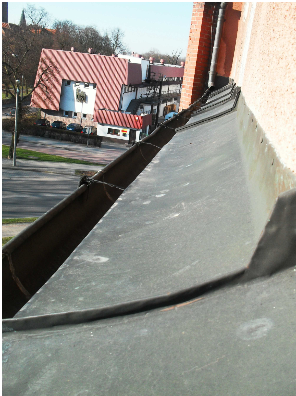
Fot. Nr 24 Parapet zewnętrzny– okno typ 6
