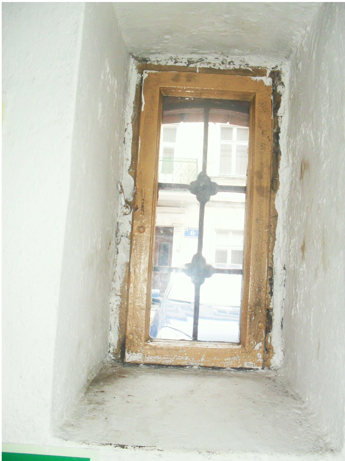
Fot. Nr 19 Okno typ 8 widok od wewnątrz
