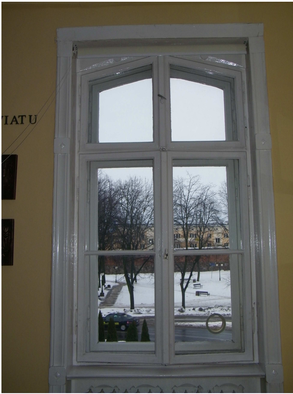
Fot. Nr 1 Okno typ AII widok od wewnątrz
