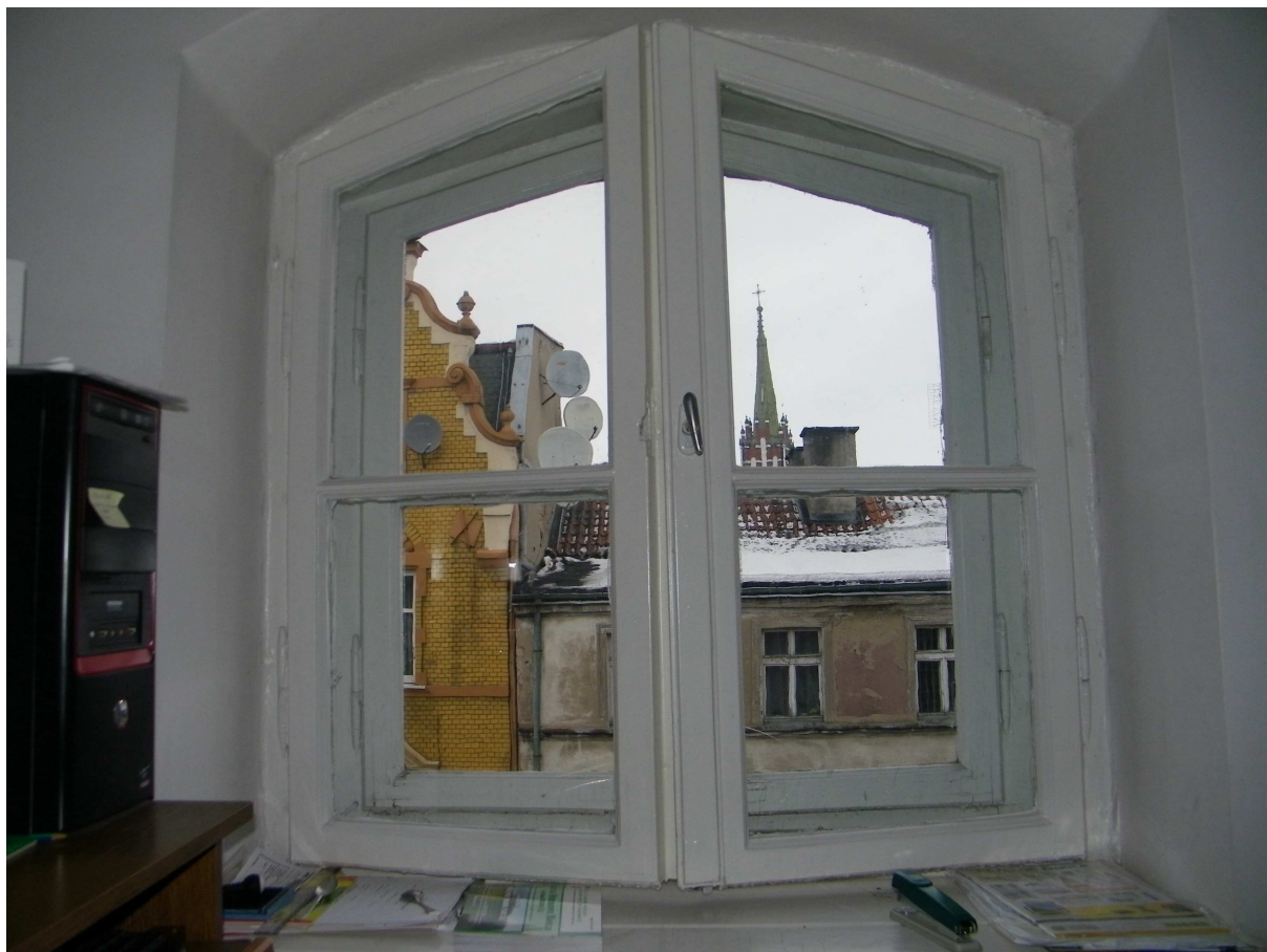
Fot. Nr 3 Okno typ B II widok od wewnątrz
