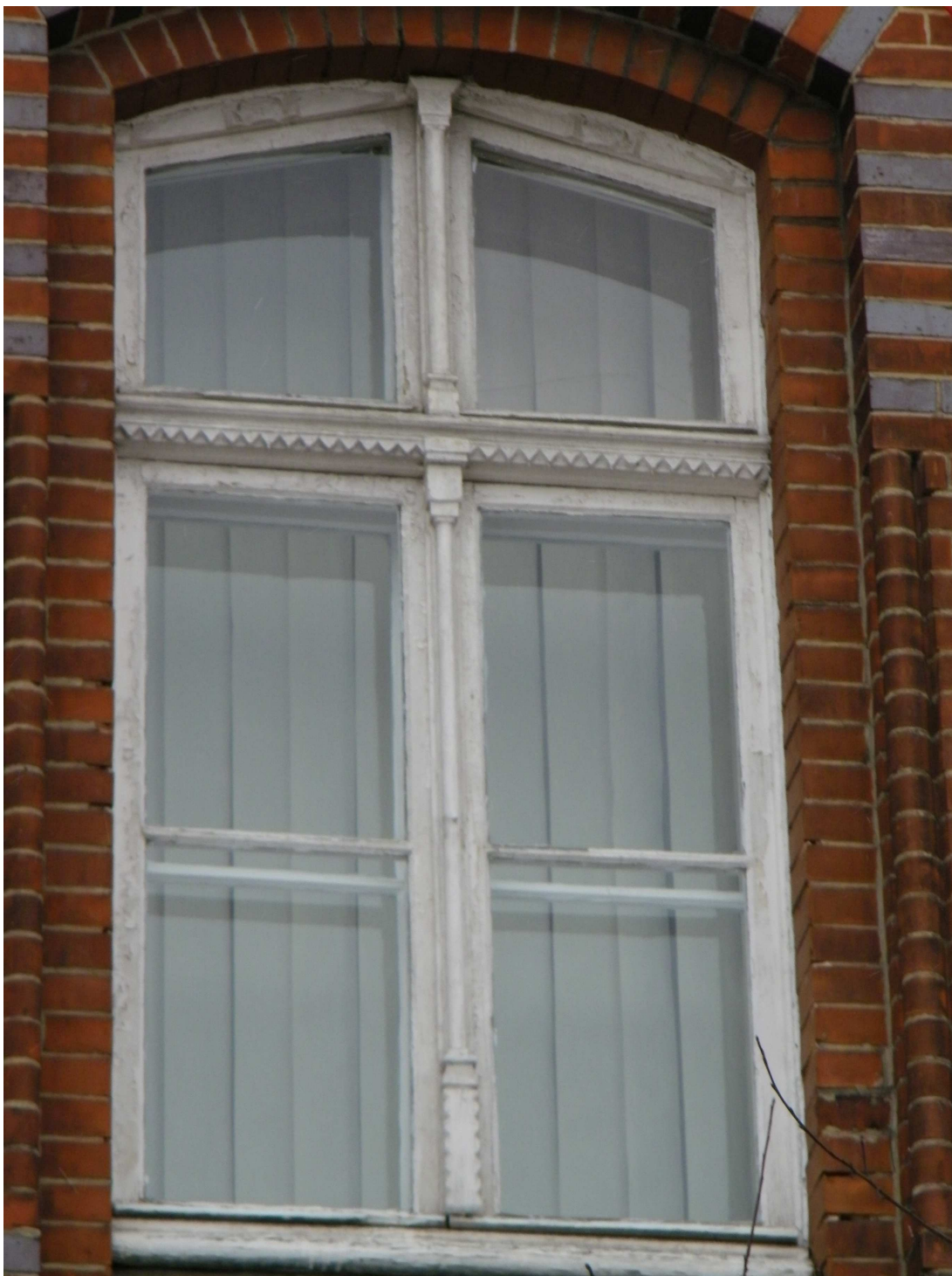
Fot. Nr 2 Okno typ AII widok od zewnątrz
