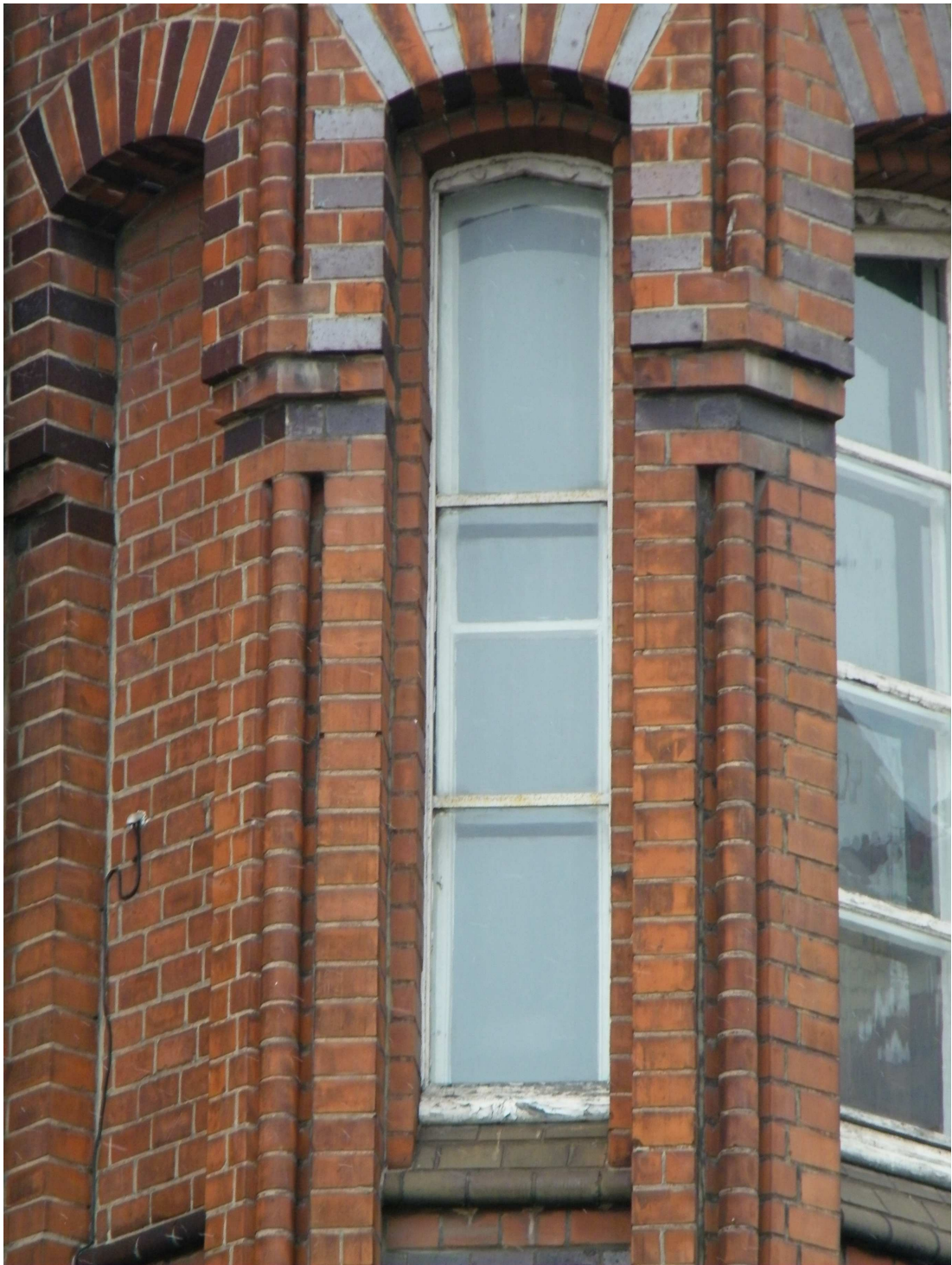
Fot. Nr 12 Okno typ 1 widok od zewnątrz
