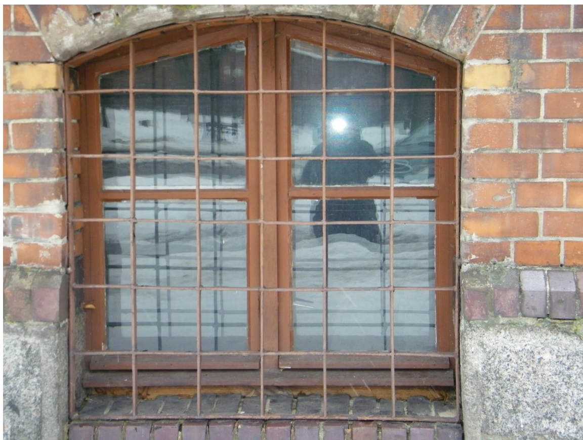
Fot. Nr 8 Okno typ 10 widok od zewnątrz
