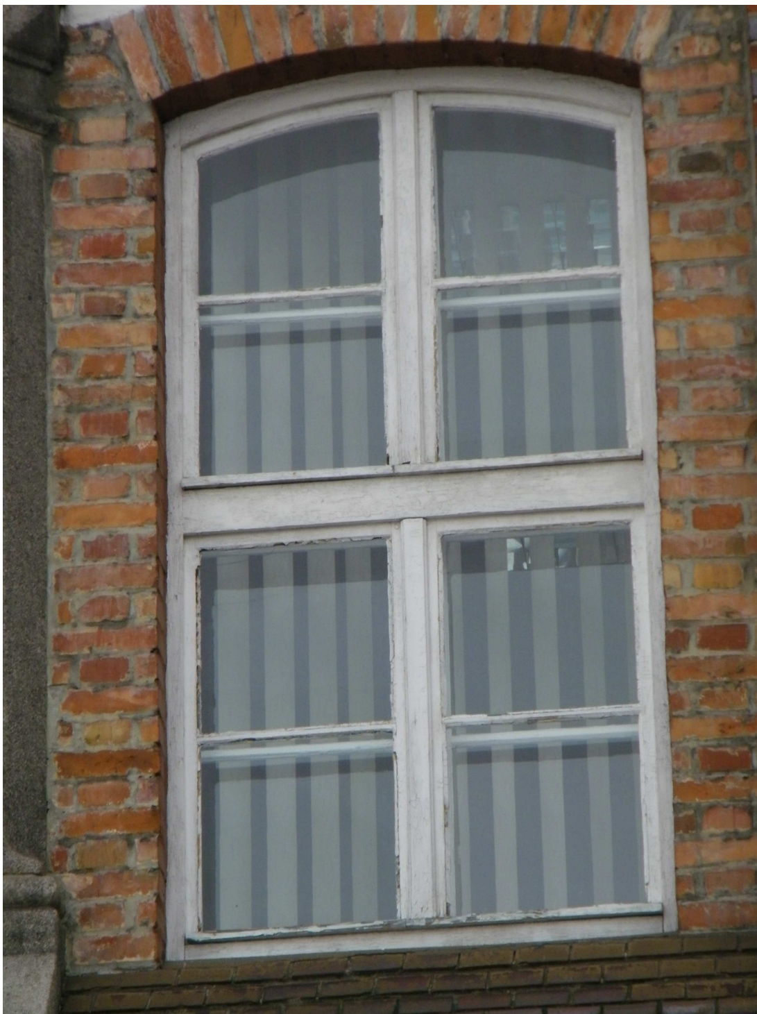
Fot. Nr 14 Okno typ 4 widok od zewnątrz
