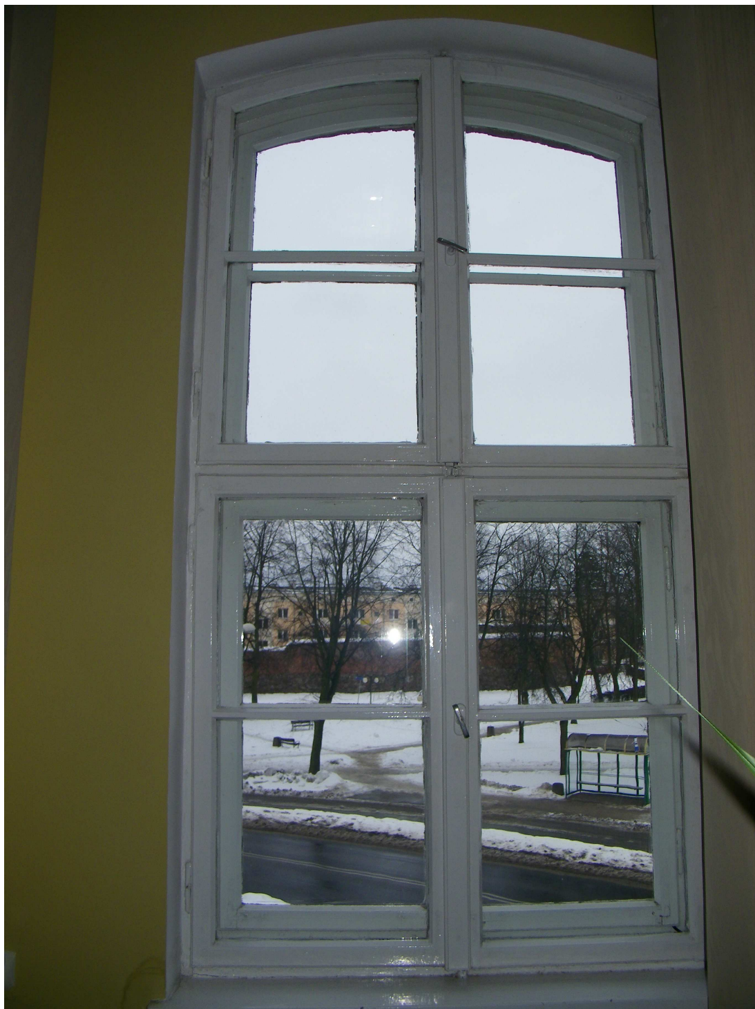
Fot. Nr 13 Okno typ 4 widok od wewnątrz
