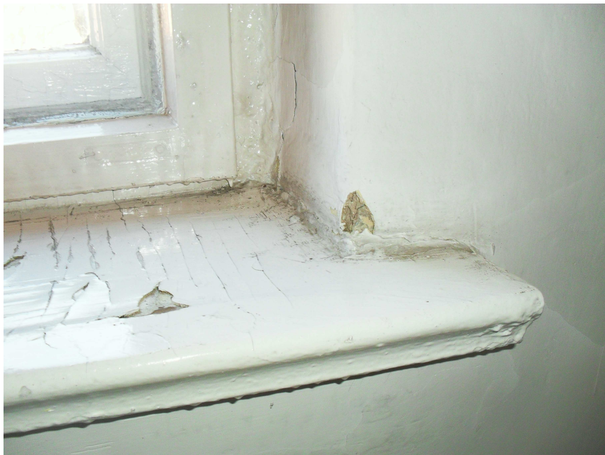
Fot. Nr 23 Parapet wewnętrzny– okno typ AIIa
