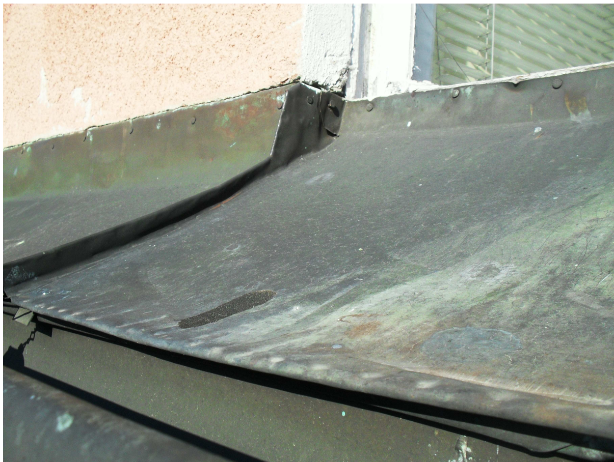
Fot. Nr 24 Parapet zewnętrzny– okno typ 6
