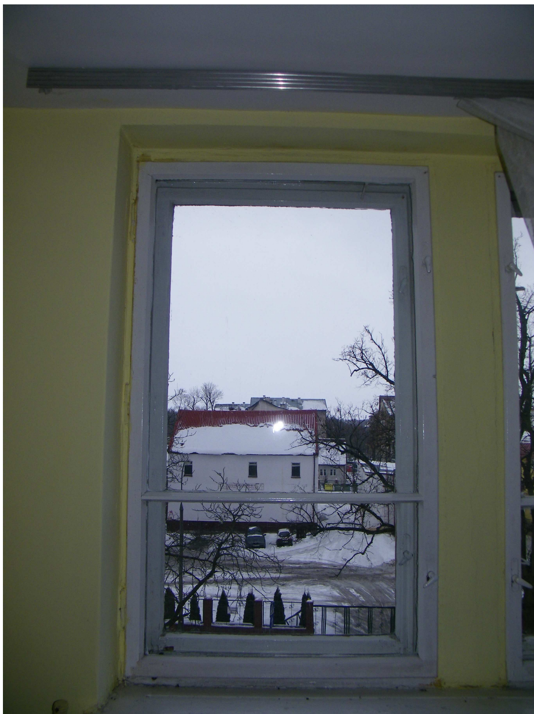
Fot. Nr 17 Okno typ 6 widok od wewnątrz
