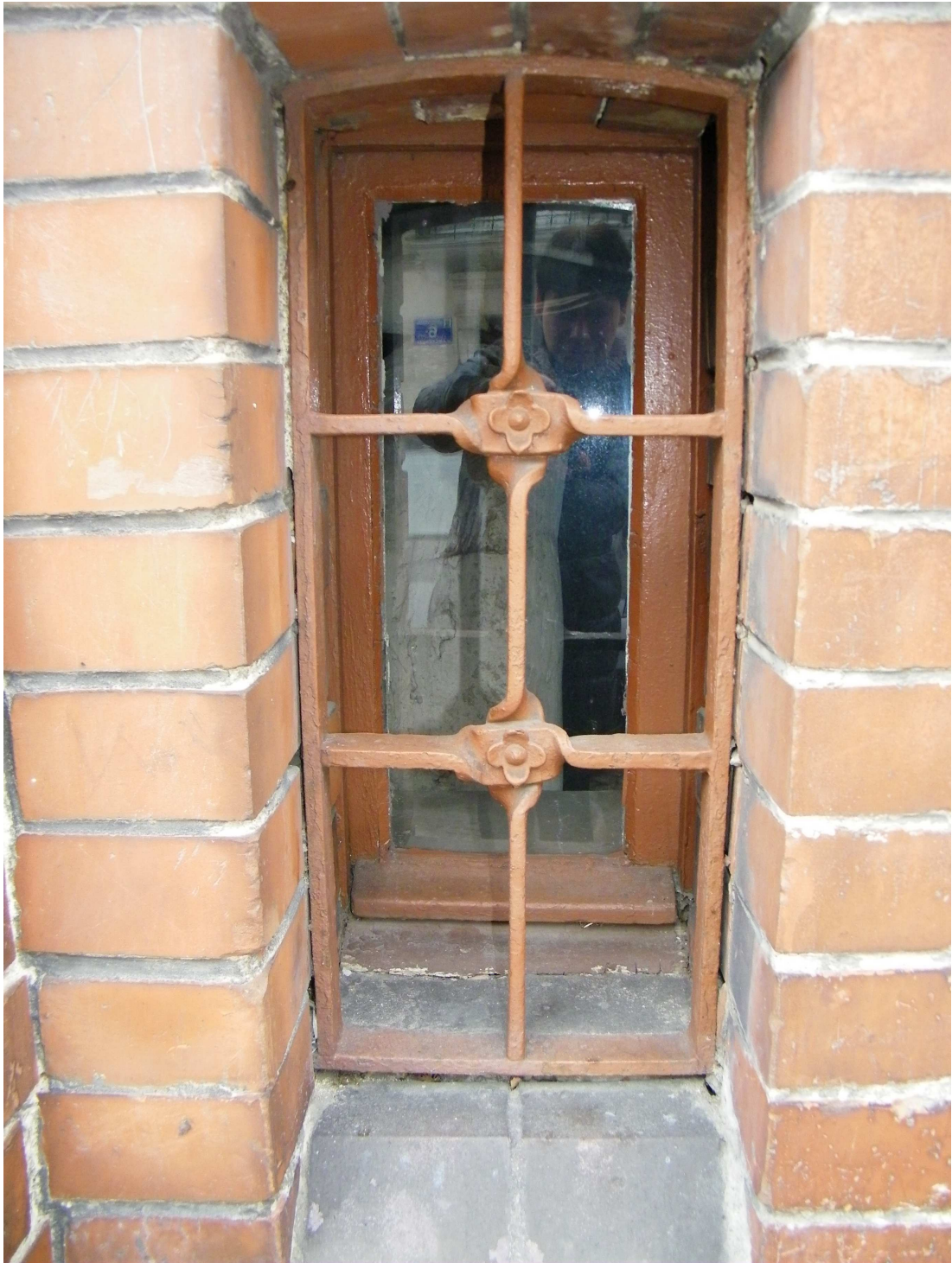
Fot. Nr 20 Okno typ 8 widok od zewnątrz
