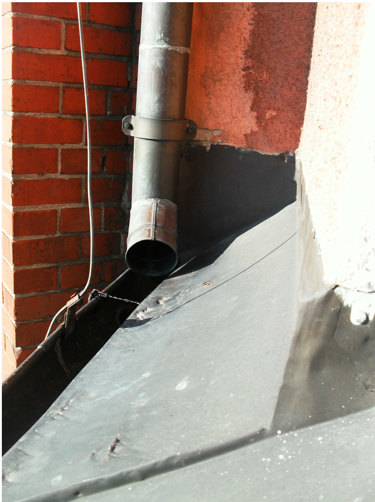
Fot. Nr 25 Parapet zewnętrzny– okno typ 6
