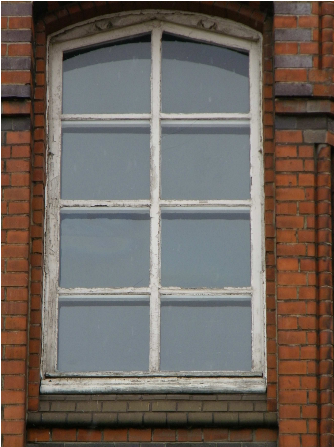
Fot. Nr 10 Okno typ 2 widok od zewnątrz
