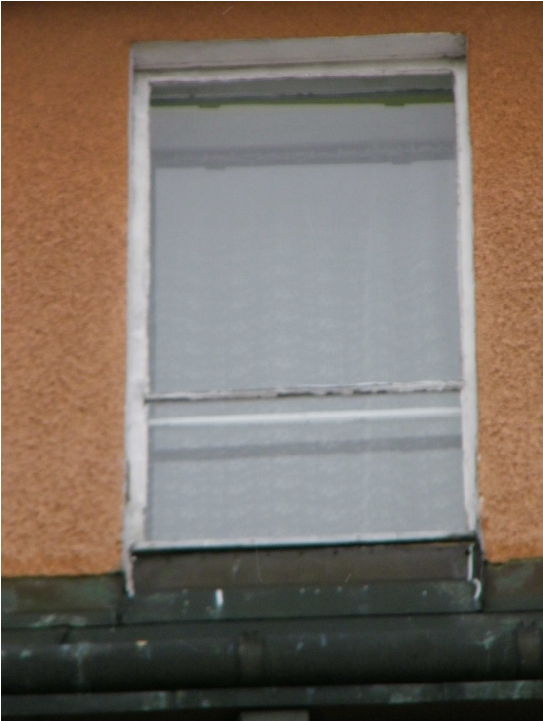
Fot. Nr 18 Okno typ 6 widok od zewnątrz
