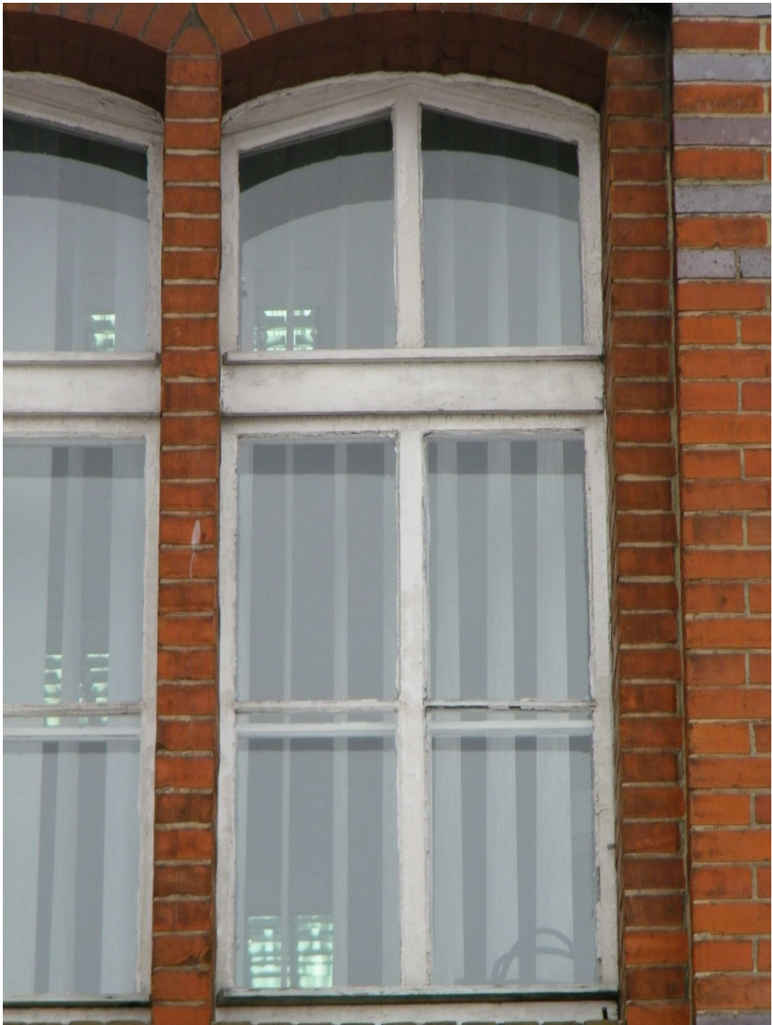
Fot. Nr 16 Okno typ 5 widok od zewnątrz
