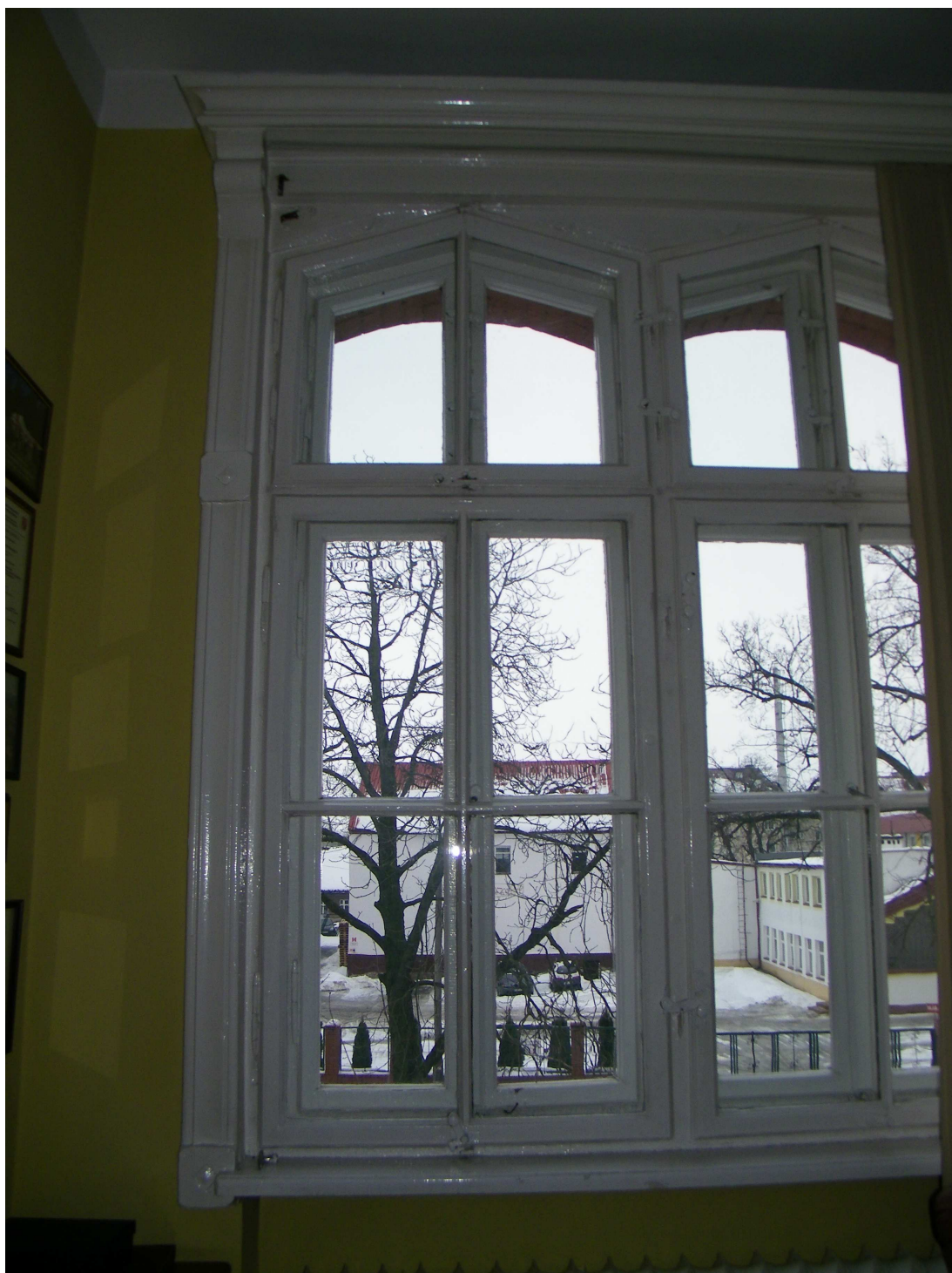
Fot. Nr 23 Portal okienny podwójny– okno typ AIIb
