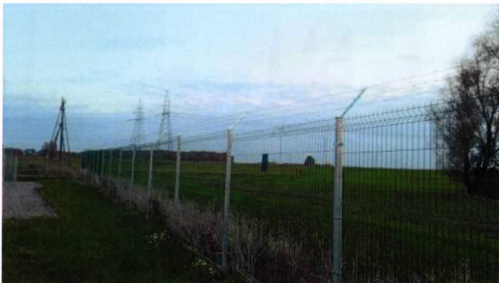
Ogrodzenie stacji GPO Pleśno II
