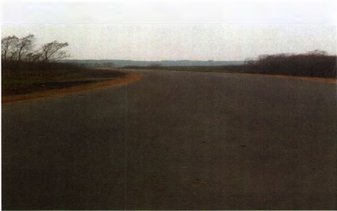
„Odbudowa drogi powiatowej nr 1581N w km 5+355 - 5+855” w miejscowości Marluty
